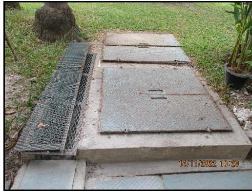
ภาพที่ 2.9 บ่อเกรอะ-บ่อซึม สำหรับบำบัดน้ำทิ้งจากสำนักงาน
