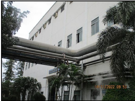
ภาพที่ 2.21 ฉนวนกันความร้อนเครื่องจักรบริเวณโครงการ WHG
