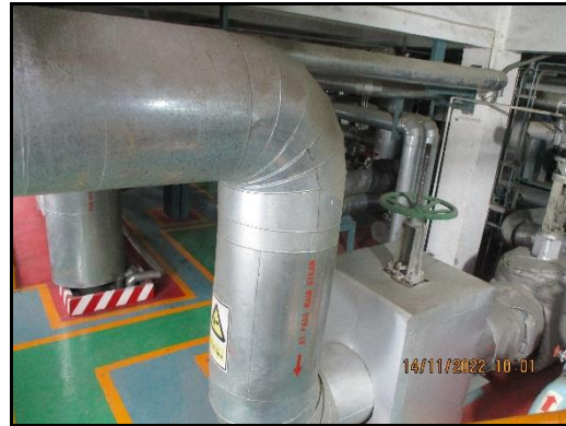
ภาพที่ 2.21 ฉนวนกันความร้อนเครื่องจักรบริเวณโครงการ WHG
