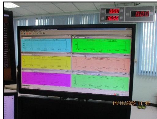
ภาพที่ 2.2 จอแสดงผลการติดตั้งเครื่องตรวจวัดฝุ่นที่ระบายออกจากปล่องหม้อเผา (CEMs) เพื่อการควบคุมปริมาณฝุ่นให้อยู่ในเกณฑ์ที่กำหนด ภายในห้องควบคุมการผลิต
